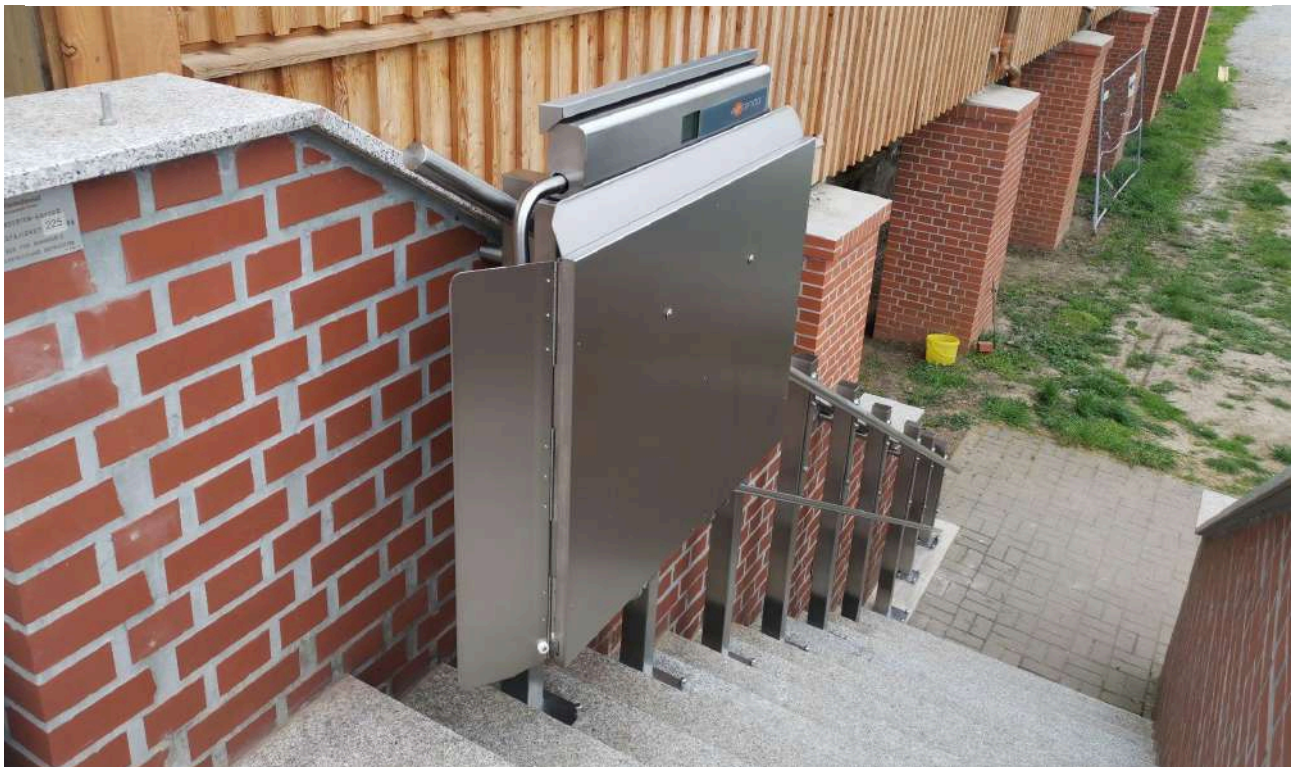
Przystanek górny - platforma złożona, montaż szyny jezdnej na słupkach samonośnych
