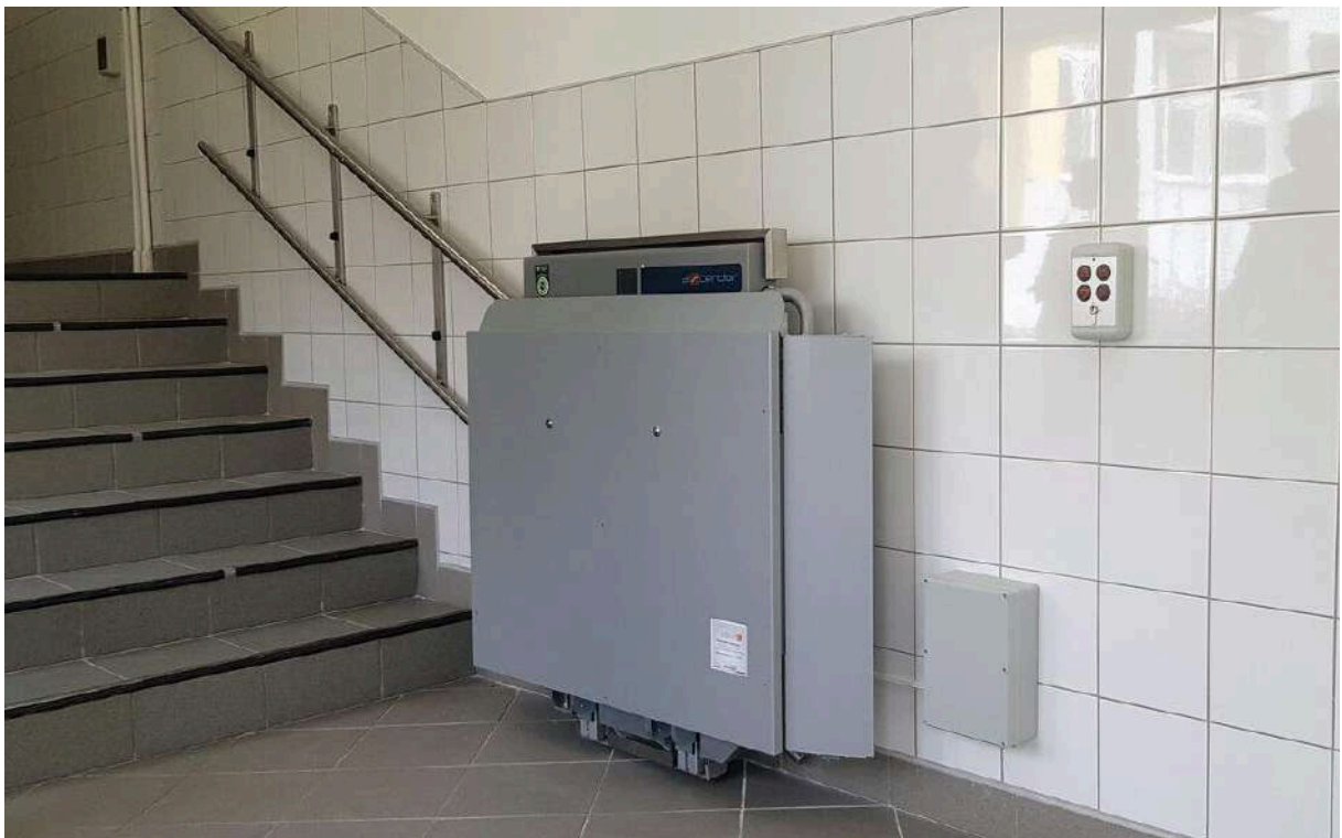
Przystanek dolny - platforma złożona. Montaż do ściany
